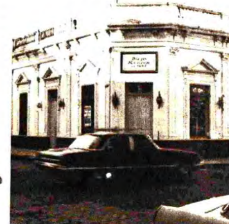
Viejo Rincón, Pavón y Rincón, en San Cristóbal.
