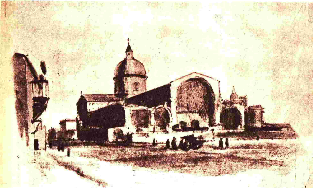
Este curioso grabado representa a la Catedral de Buenos Aires con su frente tapiado por causa del derrumbamiento de sus dos torres. En iglesias como éstas el canto y la ejecución de órgano matizaban las fiestas religiosas.
